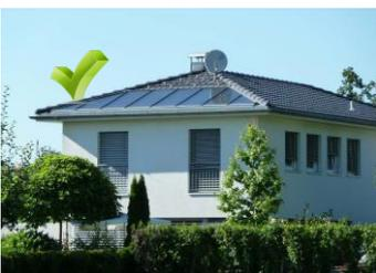
**2.1** Solaranlagen sind dachbündig einzubauen, jedenfalls darf der Kollektoraufbau maximal 20 cm betragen. Dieser wird im Bereich der Anlage rechtwinkelig zur Dachfläche bis zur Oberkante der Anlage gemessen.
