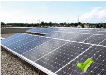
**3.1** Aufgeständerte Anlagen sind parallel zur Dachkante zu errichten.
