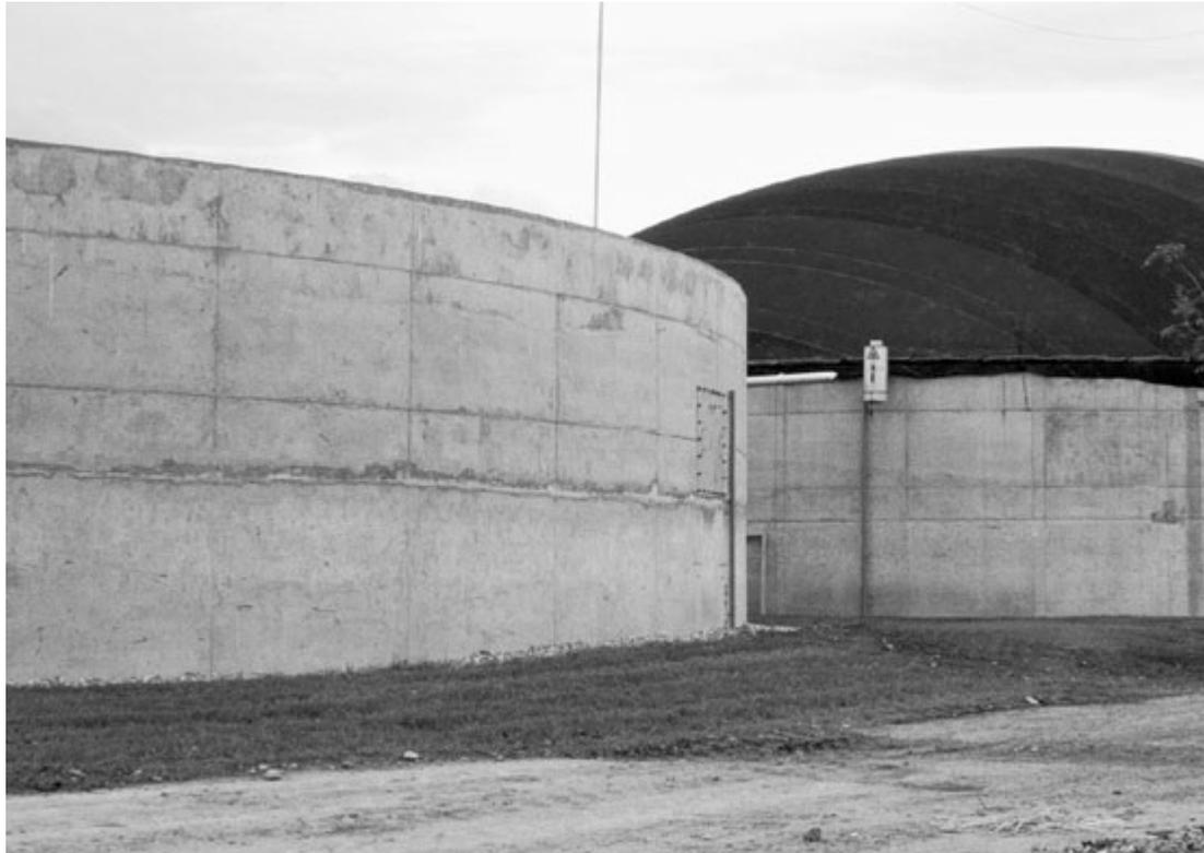
Anlage Algäuer, Haupt- und Nachfermenter einer Biogasanlage.
