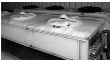
Außenkondensatoren geben keine Wärme ab, der Schnee bleibt liegen.
