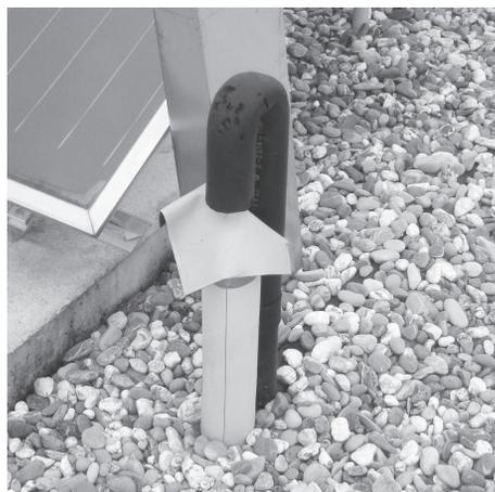
Durch die eigenartige Verrohrung sammelte sich Luft im System, deshalb ist die Anlage ohne Ertrag.
