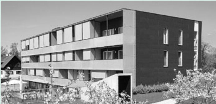
Passivhaus Vogewosi Schoren
