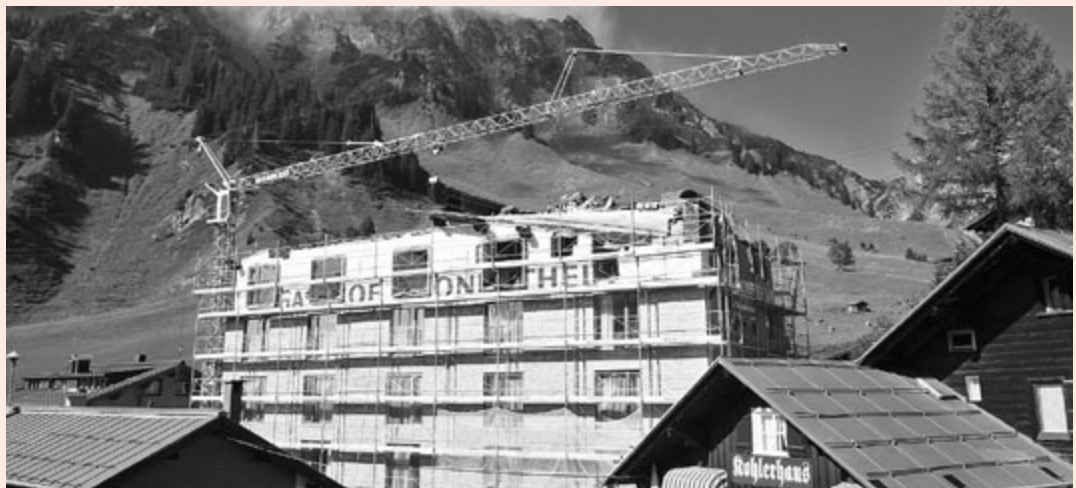
Hotel Mondschein während der Sanierungsarbeiten.
