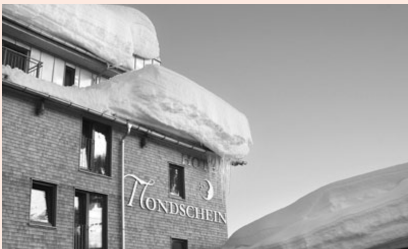
Die Sanierung hat sich im Winter 2011/2012 bereits bewährt.
