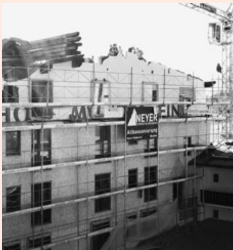
Ausbau des ehemaligen Dachbodens.
