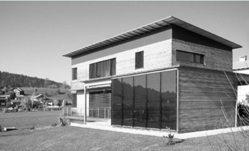
Gelungene Fassadenintegration im Nebengebäude.
