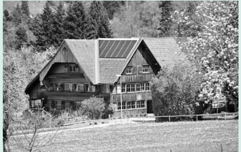
Dachintegrierte Montage spart Kosten für die Unterkonstruktion, reduziert die Verluste der Kollektorrückseite und verlängert die Lebensdauer der Anlage.
