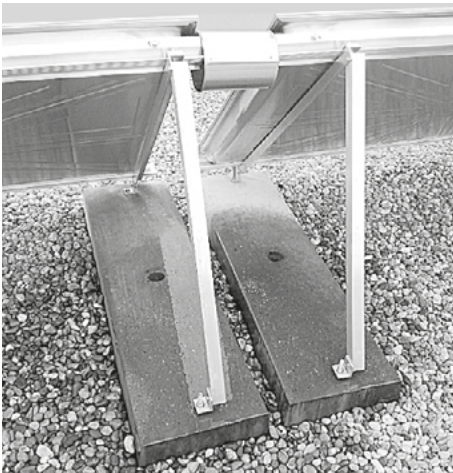
Austretende Solarflüssigkeit durch undichte Solarleitungen am Flachdach einer Wohnanlage
