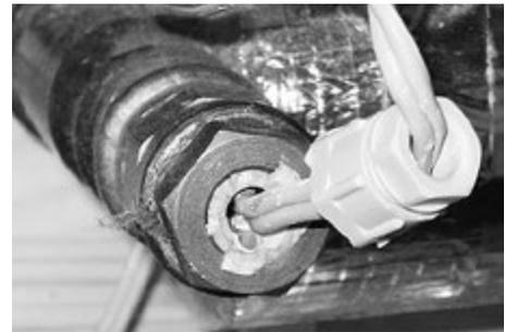
Die Funktion von Kollektorfühler oder Speicherfühler ist oftmals nicht mehr zu 100% gewährleistet. Dies kann zu deutlichem Minderertrag führen und die Sicherheit der Anlage gefährden.
